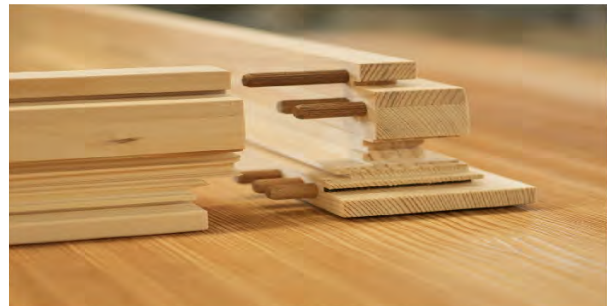
Vor allem Rahmenverbindungen neuester Generation, mit Dübelverbindungen im Fensterbau.
